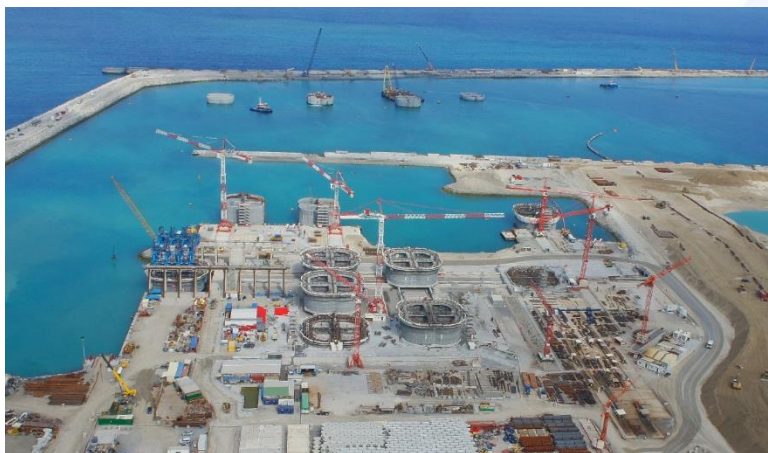
Port de Tanger Med II : préfabrication en série de 105 caissons de 5,000T
