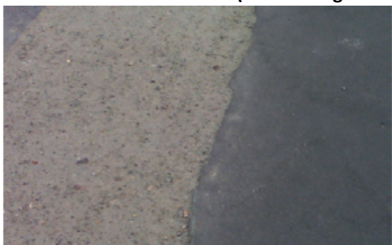
Comparaison de deux revêtements de trottoir 1h après le coucher de soleil, le 31 juillet 2011 (stabilisé à gauche et asphalte à droite).
