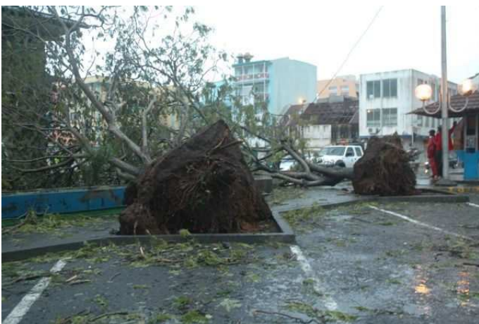
47) Dégâts après le cyclone Dean (août 2007)
