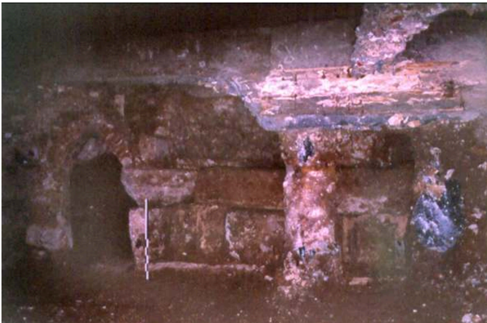
Fig. n°2 : Vue générale des fondations du rempart antique. À gauche, conduite voûtée de la fontaine Saint-Lô. À gauche, pieux de fondation de 1966
