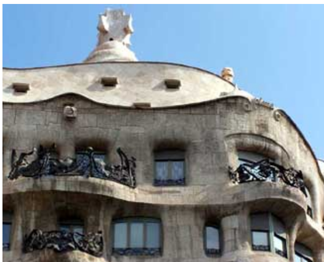
La Casa Mila ("La Pedrera")
