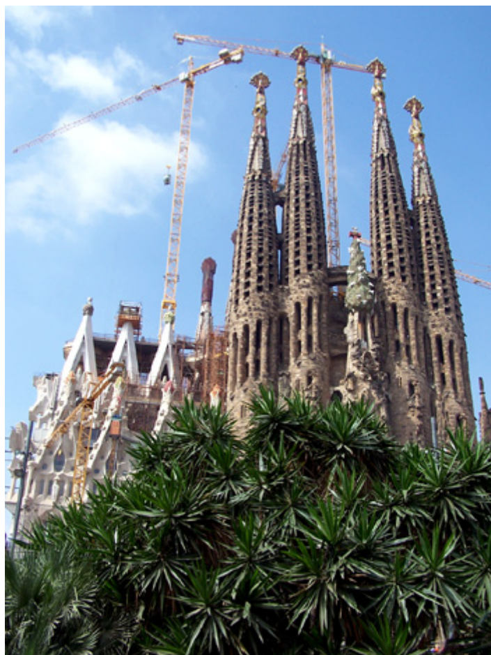
La façade de la Nativité et ses 4 tours de 115 mètres
