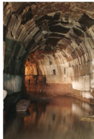
5 La Cloaca Maxima Ce canal, qui permettait d'assécher la place du Forum, a été construit vers 580 avant J.-C.
