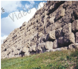
4 La muraille servienne La muraille a été construite au VI e siècle avant J.-C. par un roi étrusque, sans doute Servius Tullius (d'où son nom de « muraille servienne »).
