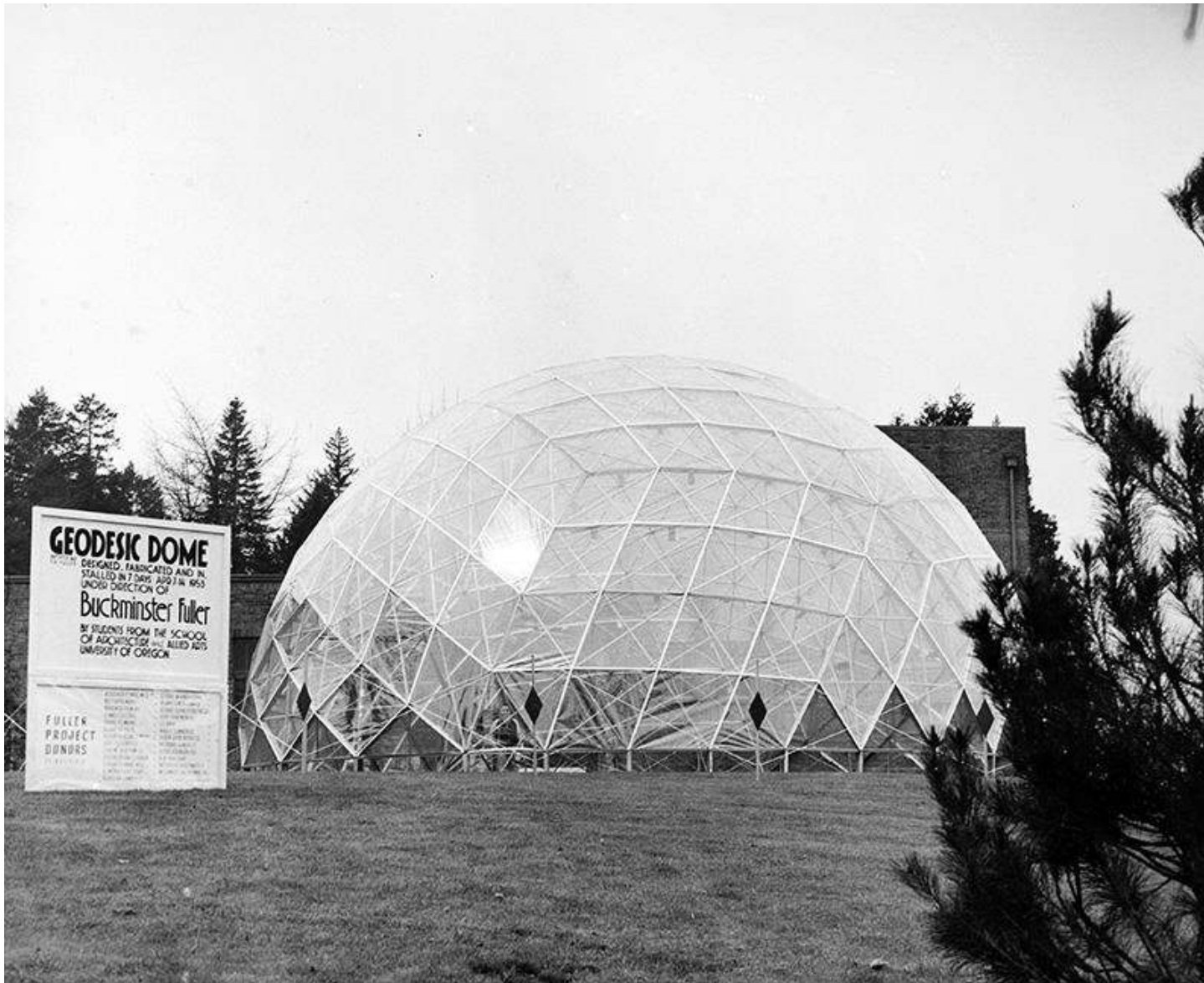
Dôme géodésique construit en 1953 (en 7 jours) par des étudiants en architecture de l'université d'Oregon sous la supervision de Buckminster Fuller
