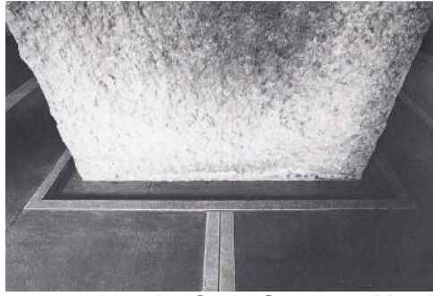
Traitement de la jonction du mur et du sol – Carlo Scarpa – Musée du Castelvechio - Vérone 1950
