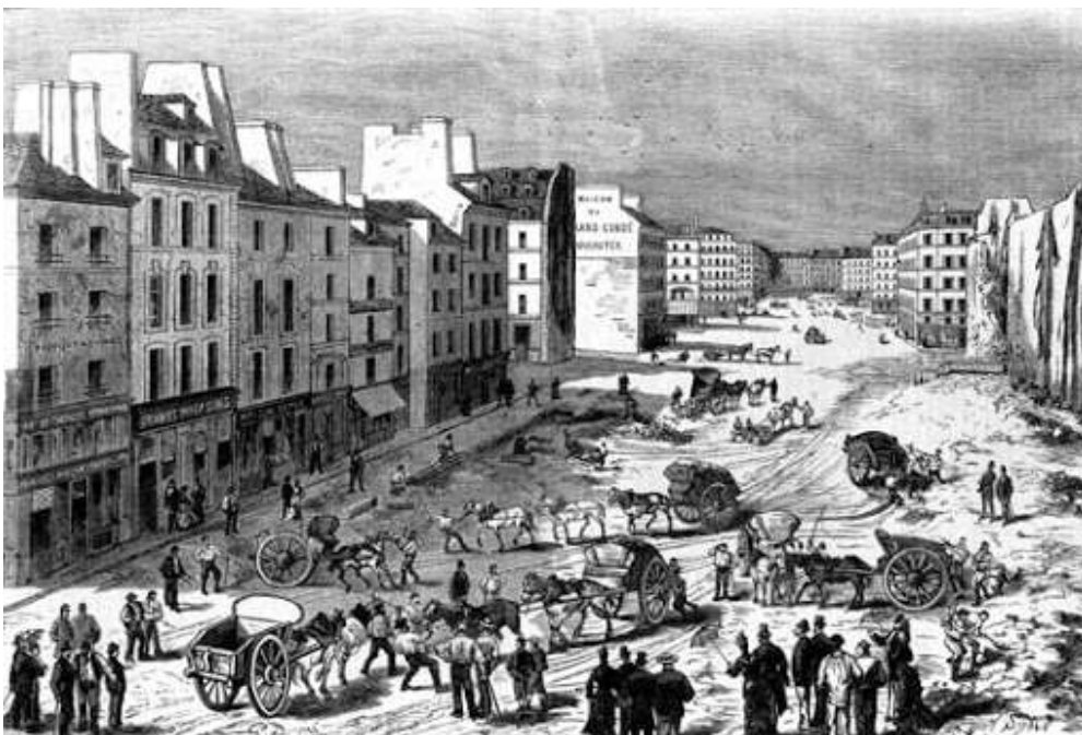
Travaux de percement du boulevard st-Germain
