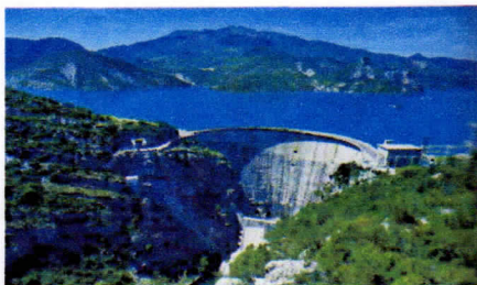
Barrage hydroélectrique de Castillon
